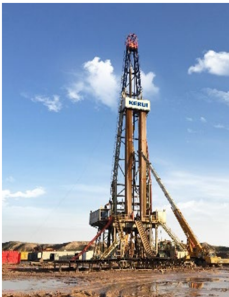
钻井工程实施
